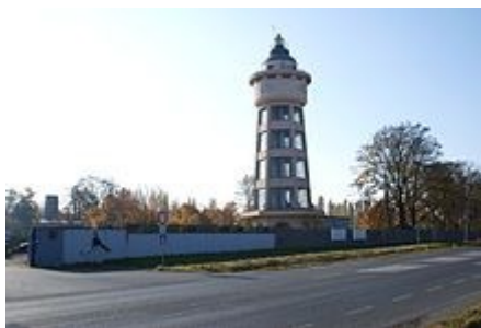
Vodárenská věž v areálu letiště
