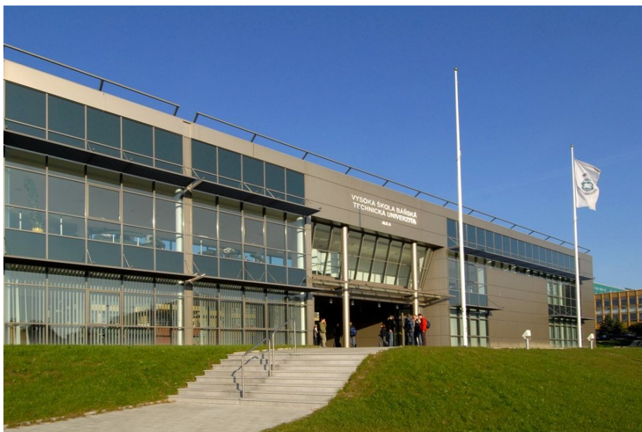
Obr. 3.1 - Aula VŠB-TU Ostrava v areálu v Ostravě - Porubě
