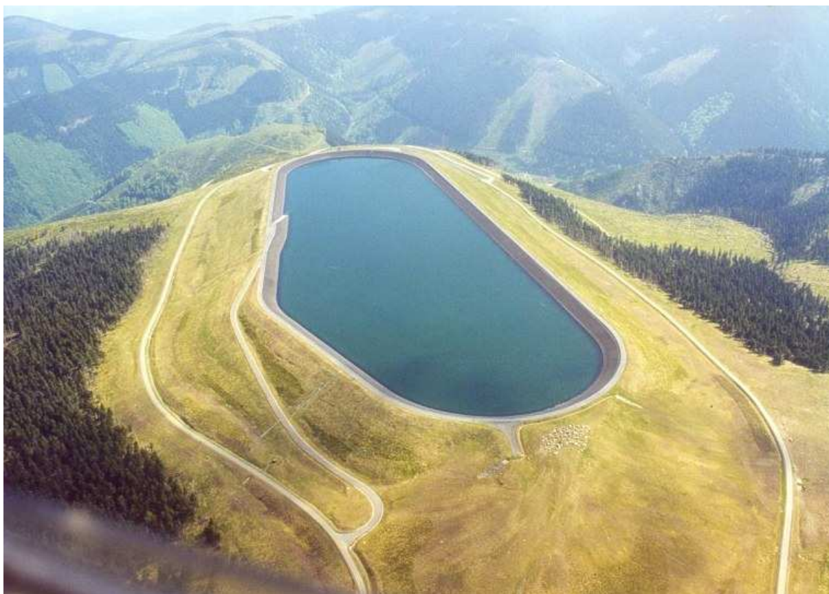
Horní nádrž přečerpávací vodní elektrárny Dlouhé Stráně (zdroj: nasemorava.cz)
