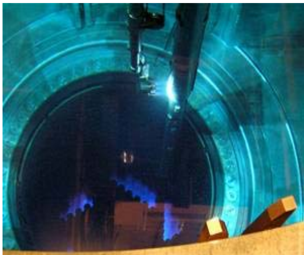
Obr. 43. Ukládání paliva do aktivní zóny
