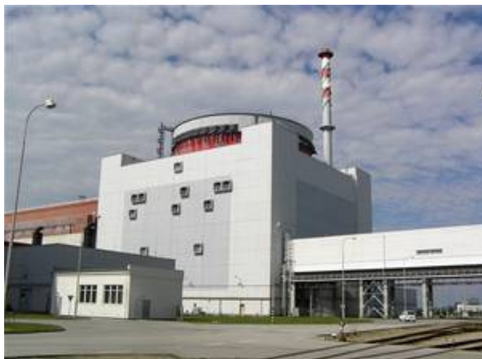
Obr.56. Bezpečnostní kontejnment
