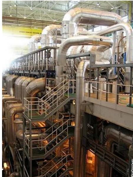
Obr.50. Turbonapájecí čerpadla
