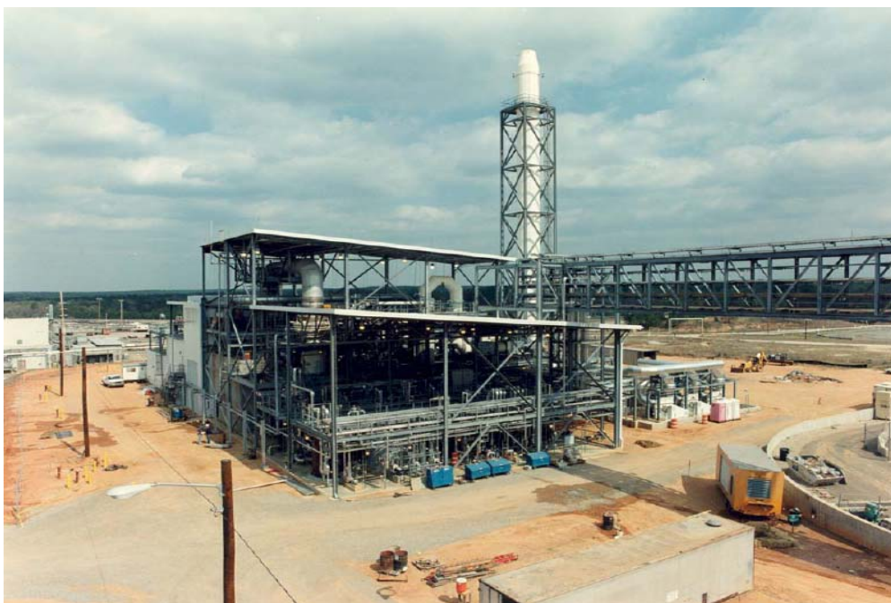
Obr. 72. Spalovna RAO-100 kg / hod s rotační spalovací komorou v Oak Ridge USA
