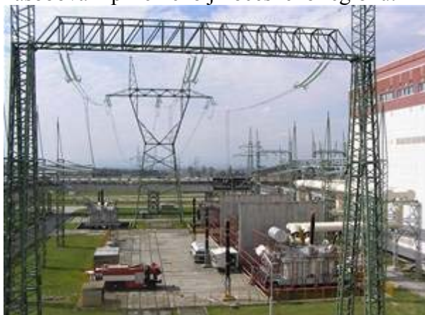
Obr.58. Vyvedení výkonu
