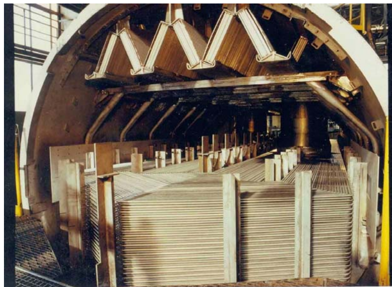
Obr.49. Záběr z montáže teplosměnných ploch parního generátoru VVER 1000 ve Vítkovcích
