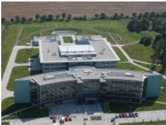
Celkový pohled na areál IATCC Jeneč
