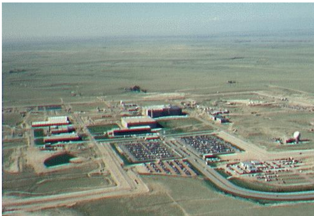
Obr. 4.3 Hlavní řídící stanice - Základna Schriever [Zdroj: Wikipedia]
