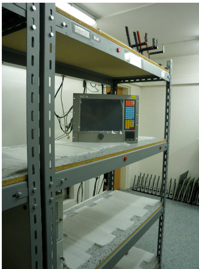
Obr. 4.10 Zahořovna ELVAC IPC s.r.o.
