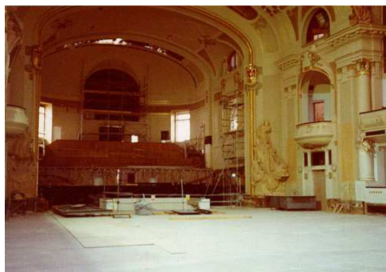
Obr. 7.1 Smetanova síň (v době rekonstrukce)
