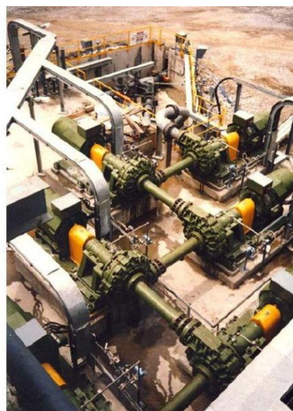
Obr. 4.16 Sériové řazení kalových čerpadel – f. Warman
