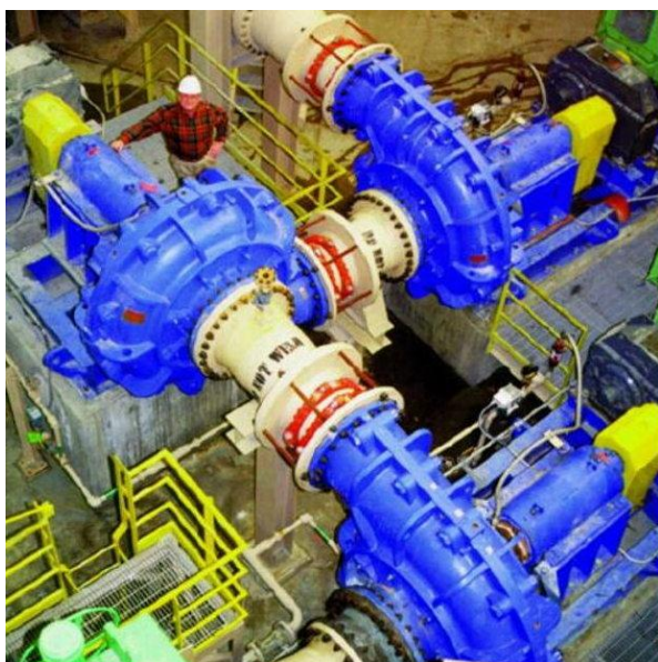
Obr. 4.16 Sériové řazení kalových čerpadel – f. Warman
