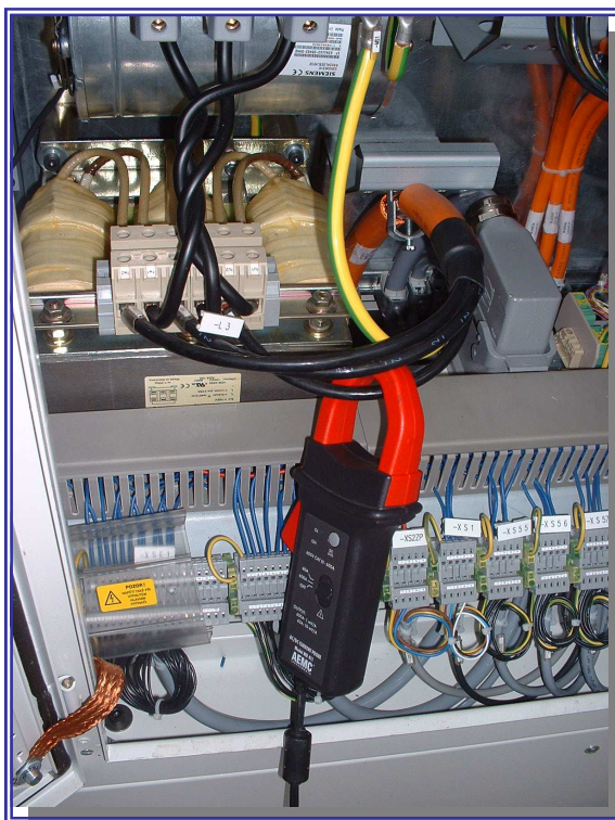
Obr. 4.6.2 - Měření napájecího proudu klešťovým ampérmetrem
