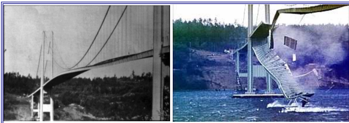
Obr. 1.8 - Destrukce mostu Tacoma Narrows
