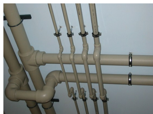
Obrázek 12-3: Příklady svařovaných dílců.
