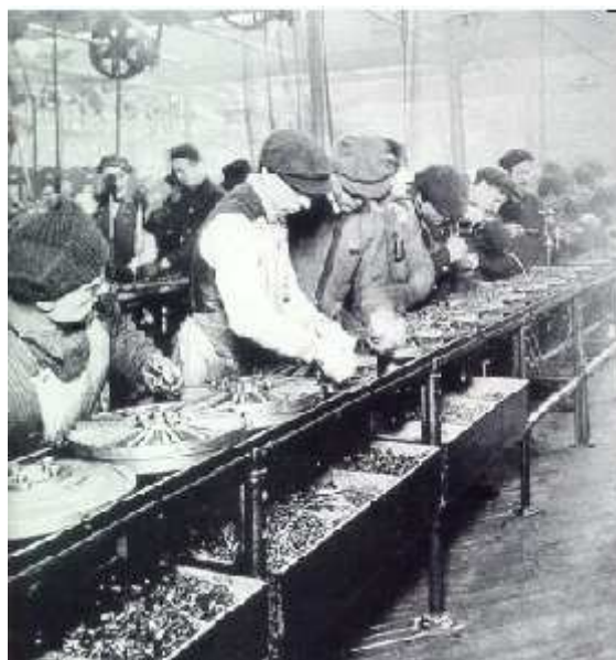
Obr. 43 Montážní pohyblivý pás ve Fordových závodech
