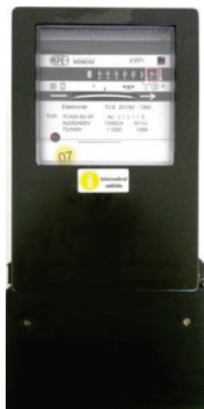
Obr. 18 Příklad provedení indukčního trojfázového elektroměru.
